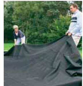
Étanchéité toiture-terrasse en caoutchouc EPDM
