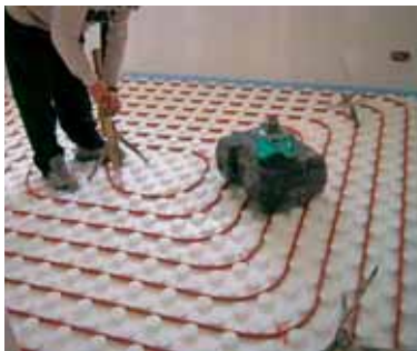
Mise en place des trépieds.
