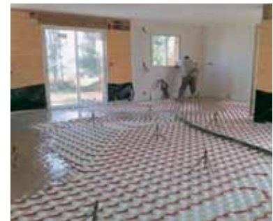
Coulage de la chape liquide béton.
